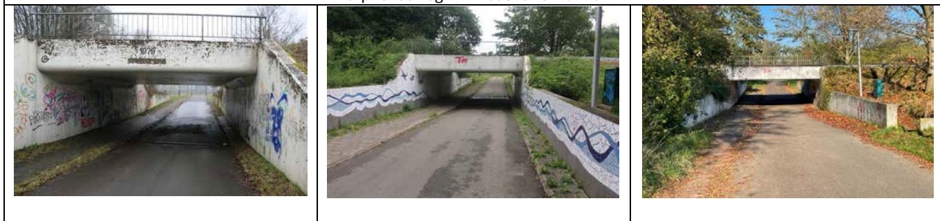
Fietstunnel Stormbaan - Ensinkweg
